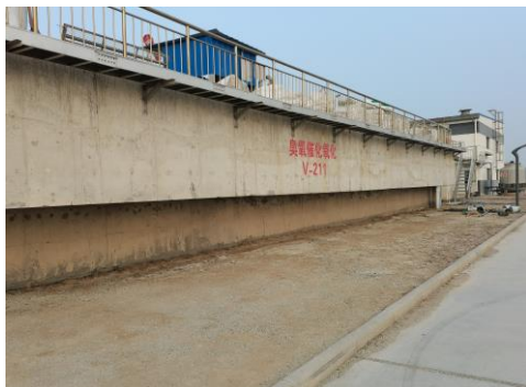
臭氧催化氧化池（反硝化滤池）
