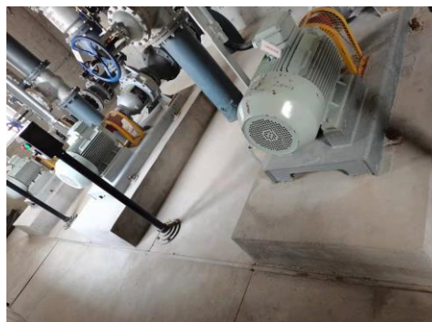
反洗水泵减震措施
