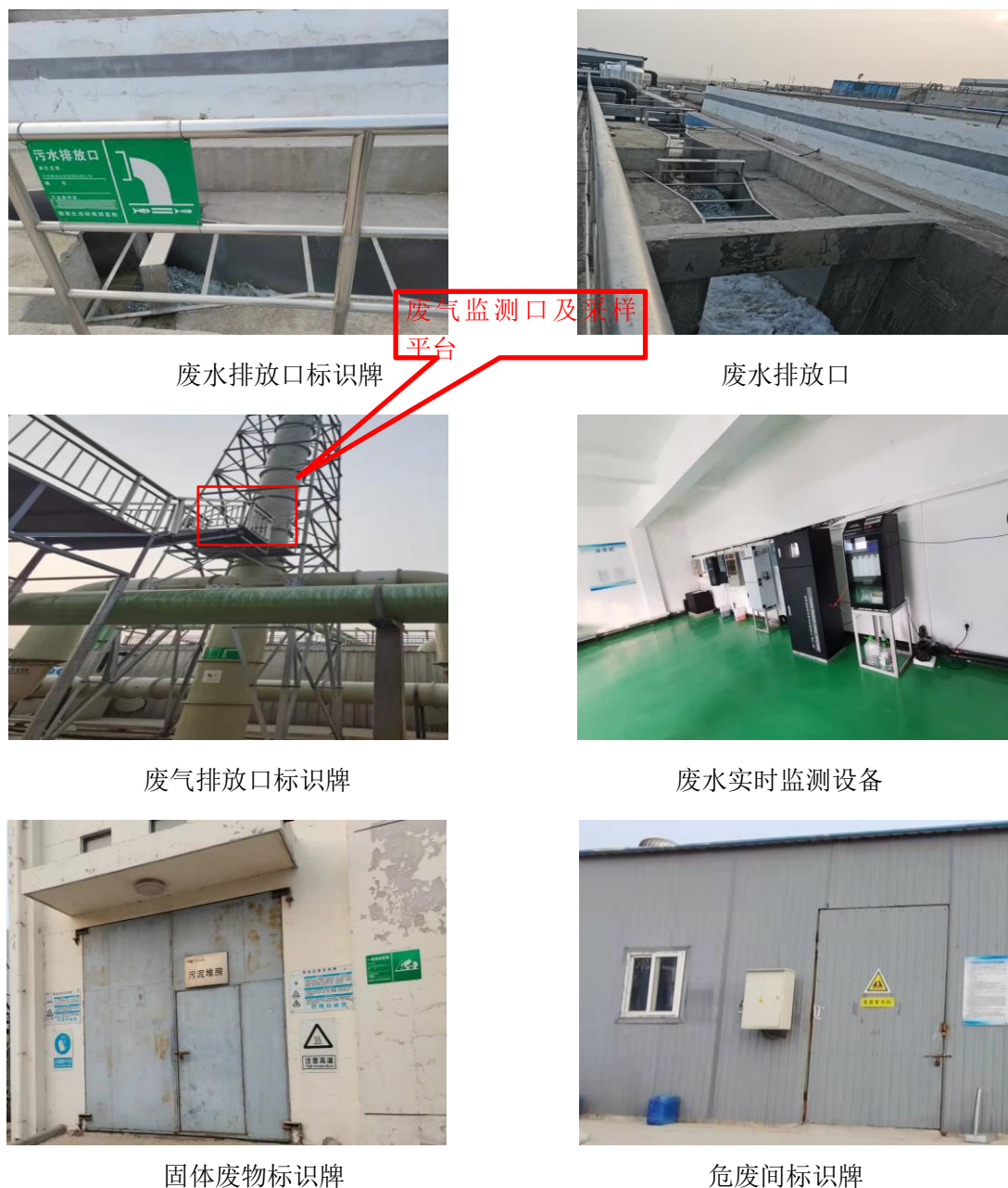
图 4.3-4 本项目排污口标识牌
