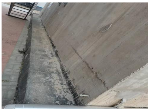
混凝池防渗措施
