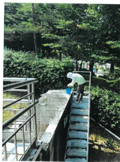
生产废水出口
