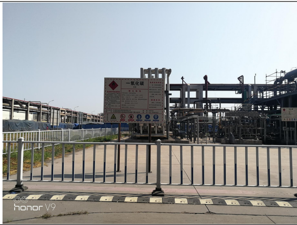
醋酸装置区-CO膜制气装置
