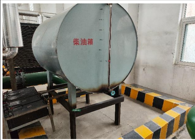
醋酸装置区柴油罐
