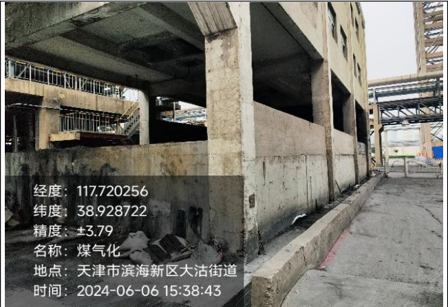
煤气化装置区煤渣堆场
