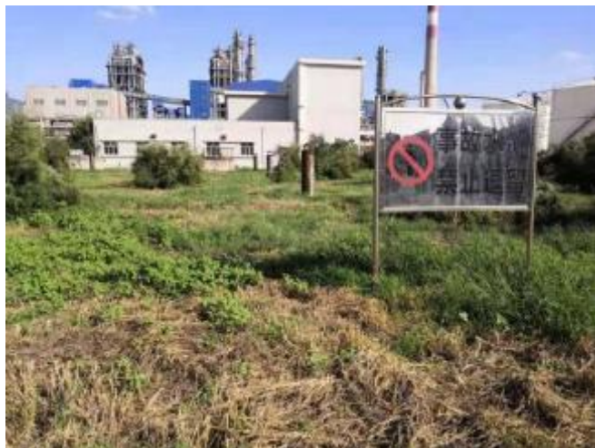
1#事故水及初期雨水池
