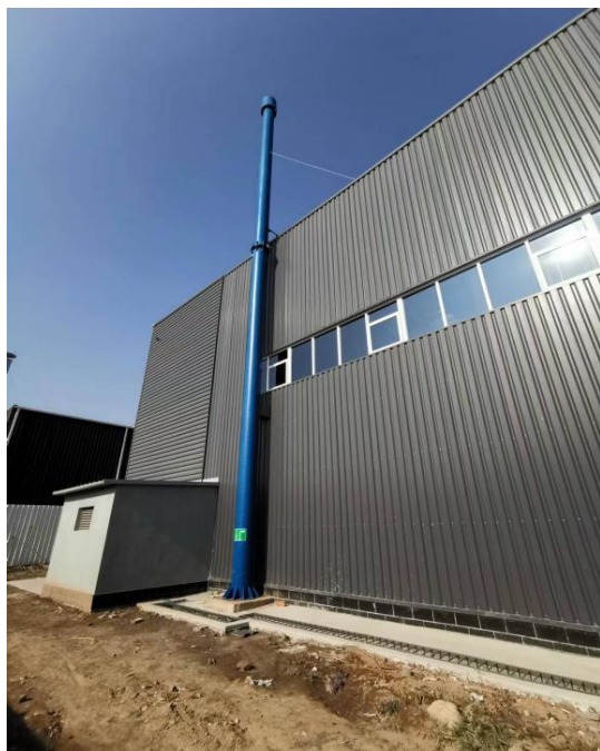
排气筒 P22 采样平台及标识牌
