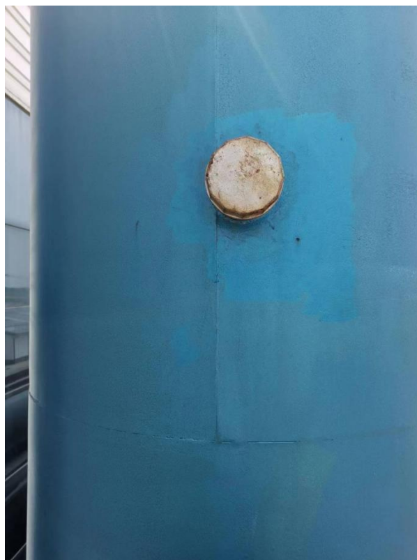
排气筒 P15 采样口
