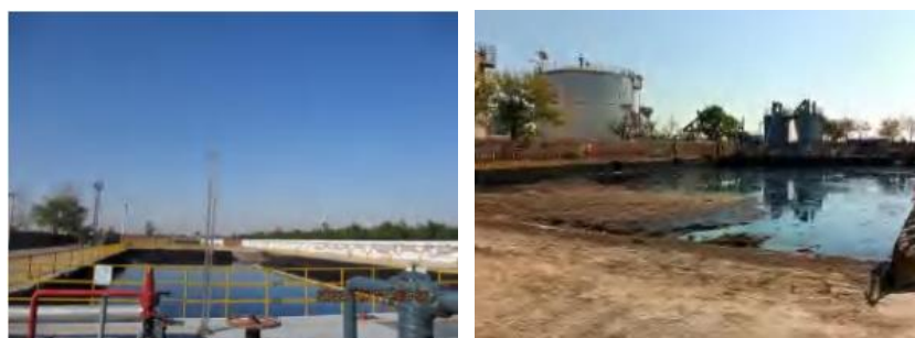
图 3.10-2 西一联大沉砂池 图 3.10-3 西二连大沉砂池
