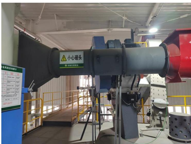
图 7-1 脉冲布袋除尘器连接处
