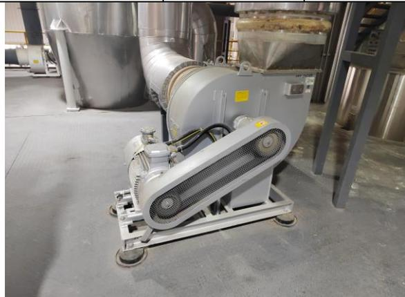
减振基础（减振垫）
