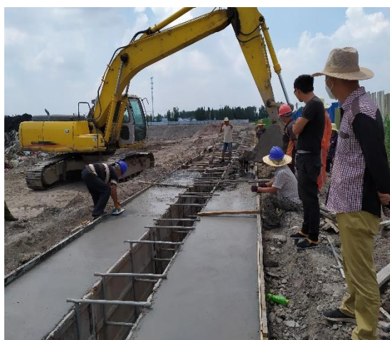
场外道路施工
