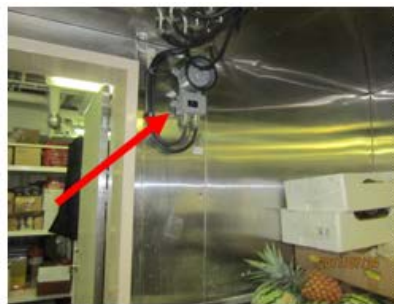
冰库：壁板，消耗臭氧物质 (HCFC141b)>1000mg/kg，2020年前可用
