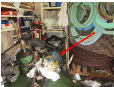
备品备件：垫片，温石棉 (0.1%-5%)，不同规格/不同厂家的垫片均含石棉，而且船员已将其广泛使用到各设备中
